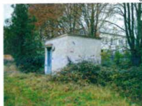
objekt - sklad chlóru na parc. č. 3955
